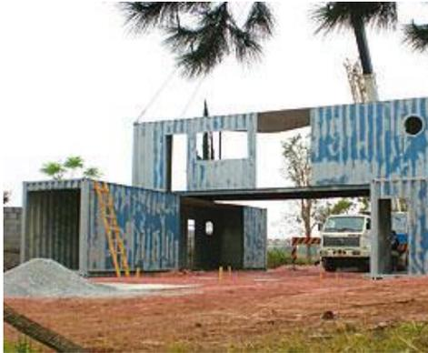
Figura 4 – Posicionamento dos Contêineres (CALORY, 2015)
