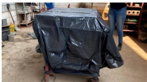
**Figura 4:** Início do processo de cura dos tijolos
